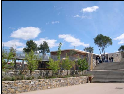
Passerelles et accès aux classes situées au niveau supérieur
