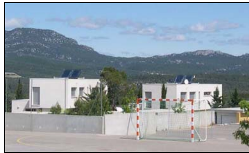
Logements de fonction avec panneaux solaires pour chauffe-eau
