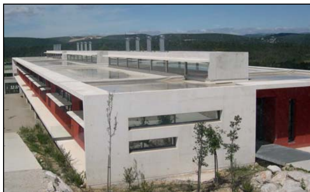
Vue extérieure sur les tourelles sortant du bâtiment
