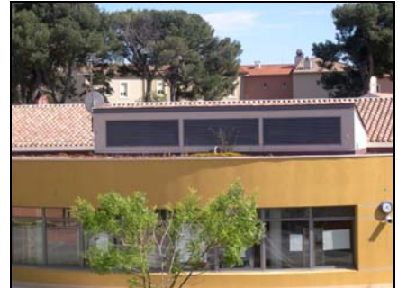
Toit du CDI végétalisé
