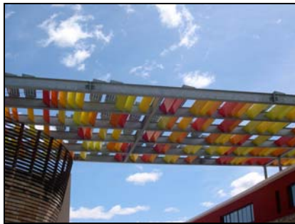
Auvent d'entrée avec capteurs photovoltaïques
