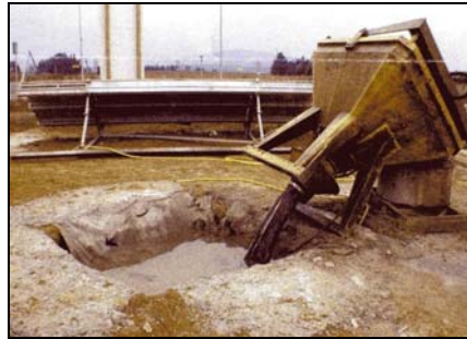
Aire de récupération des laitances du béton
