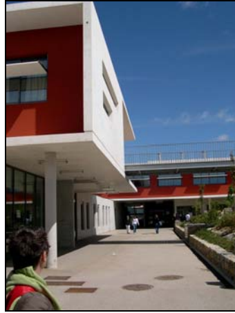
En bas g. : le bâtiment d'accueil perpendiculaire aux salles de cours
