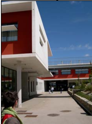
Bâtiments à l'entrée du site
