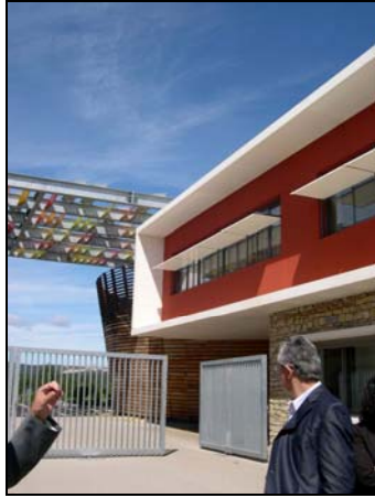
Entrée du lycée et bâtiment d'administration
