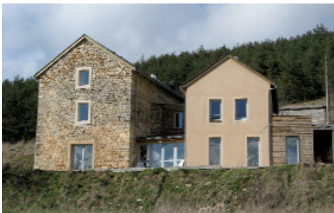
Construction mixte, La Capelle - Architecte : Marie-Claire Bessin
